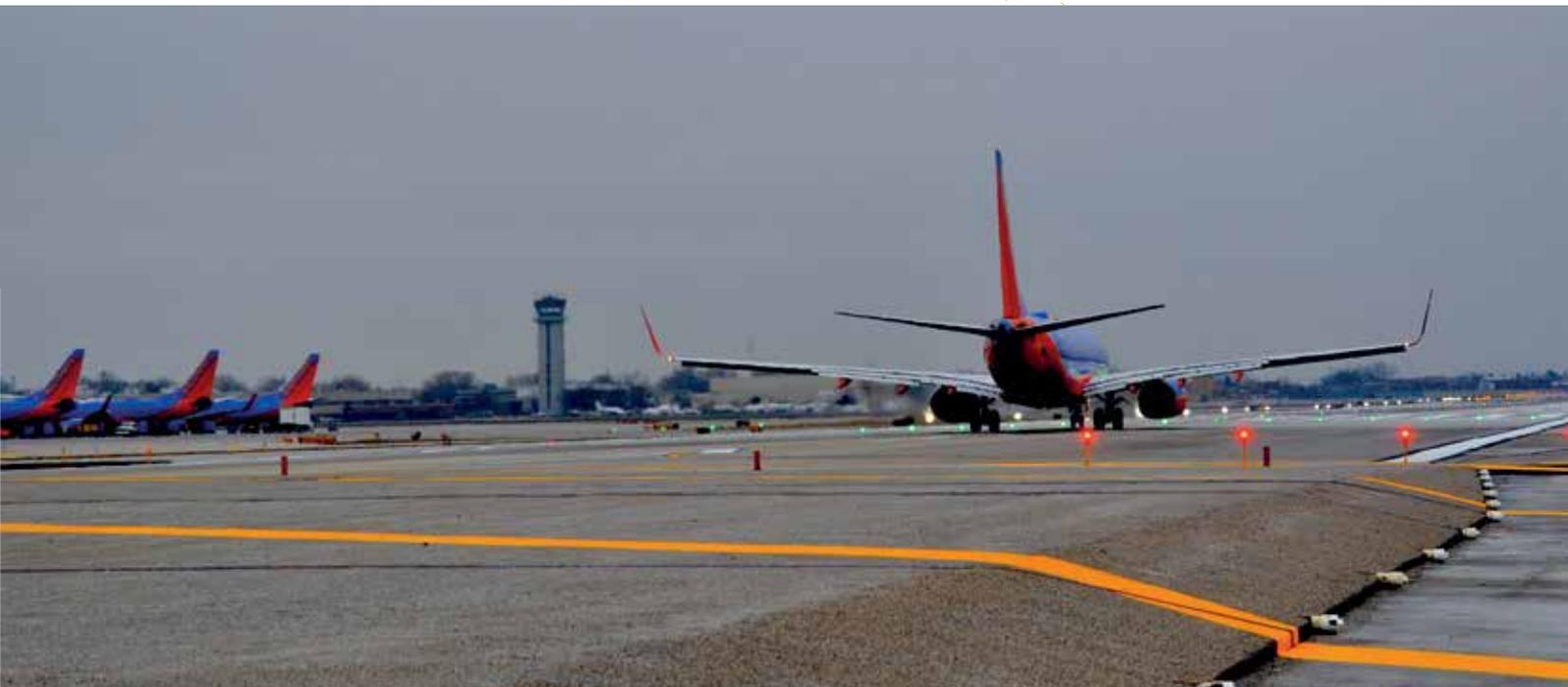
Die Oberkante des EMAS liegt etwas oberhalb des Pistenniveaus. Das Foto zeigt das von „Runway Safe“ installierte EMAS in Chicago-Midway.
